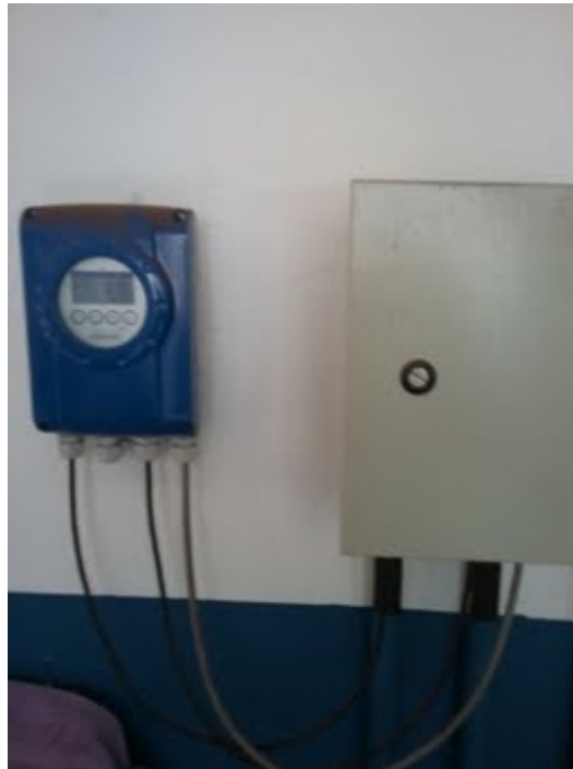
Descrição(7): Amostrador digital das vazões do medidor de carretel na saída do poço
