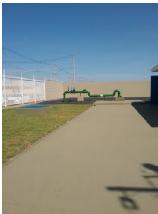
Descrição(2): Local do poço com gradeamento
