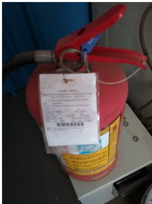
Descrição(6): Carga do extintor de incêndio com prazo de validade vencido
