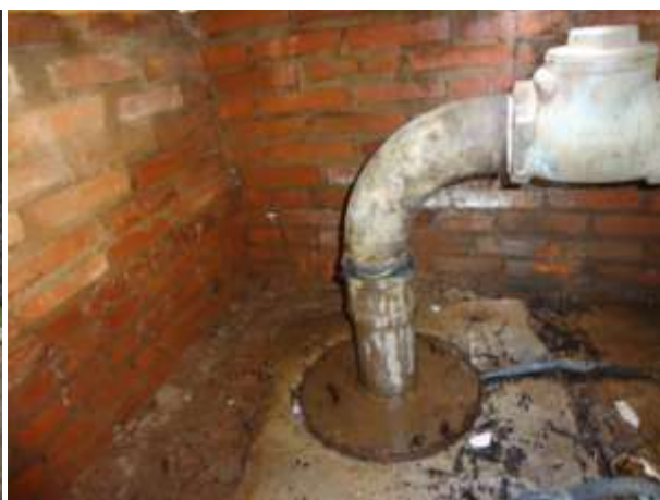
Figura 6 - Laje de Proteção do Poço Almojarifado
