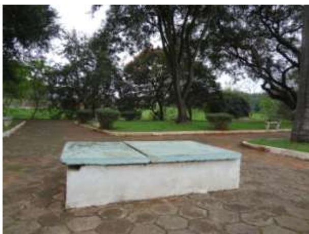
Figura 5 - Aspecto do Poço Almojarifado
