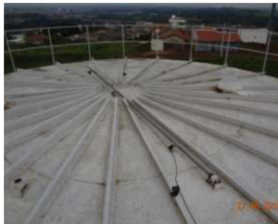
Figura 14 – Cobertura do reservatório em aço
