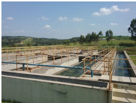
Descrição(6): Guarda-corpo em estado precário (oxidação)
