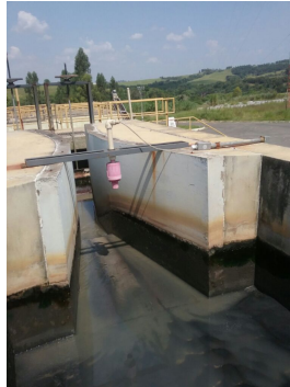
Descrição(2): Calha Parshall com medidor ultrassônico Imagem(3)
