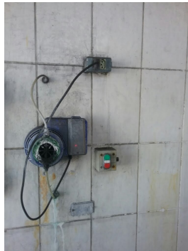
Descrição(5): Correção pH com carbonato na água tratada Imagem(6)
