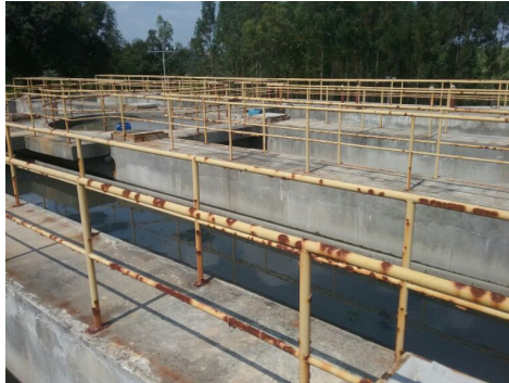
Descrição(6): Guarda-corpo em estado precário (oxidação)
