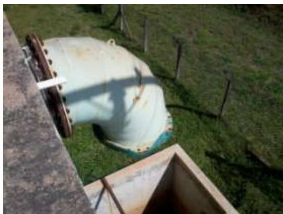
Figura 40 - Detalhe da tela de proteção do tubo extravasor
