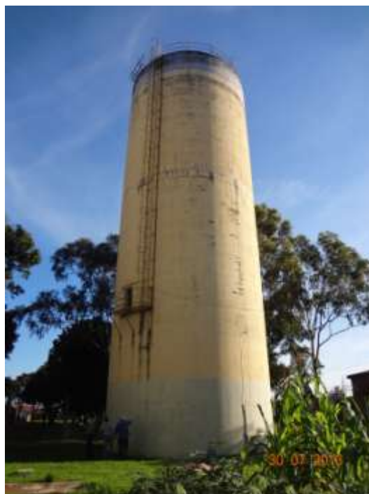
Figura 33 - Reservatório apoiado 4.000 m 3
