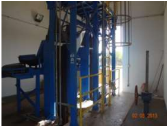
Figura 48 - Gradeamento Grosso
