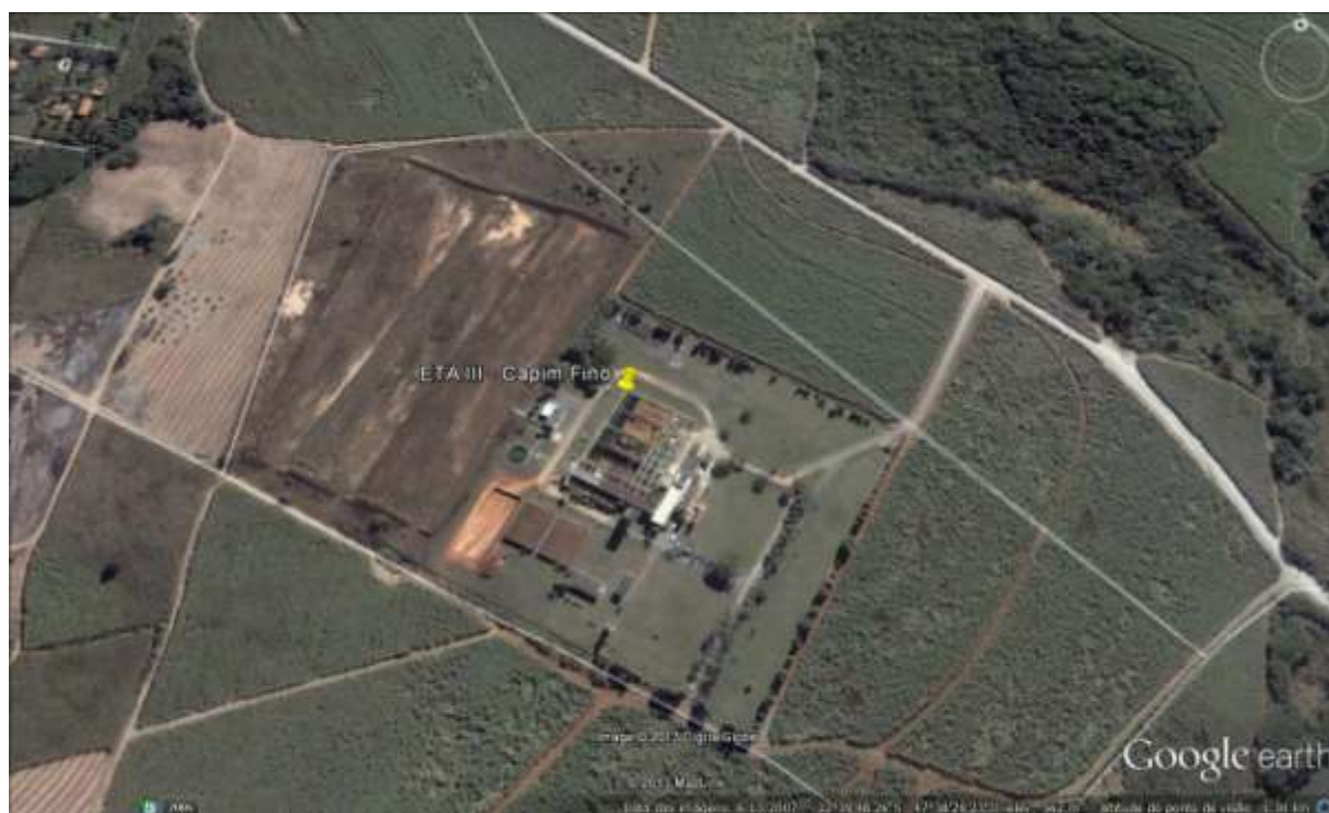
Figura 14 - Imagem de satélite da Estação de ETA III Capim Fino
