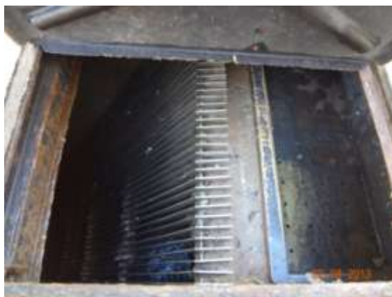
Figura 42 - Gradeamento Grosso EEE
