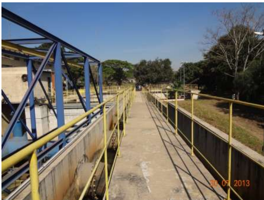
Figura 7 - Captação III Rio Corumbataí
