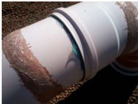
Figura 39 - Detalhe da tela de proteção do tubo de ventilação
