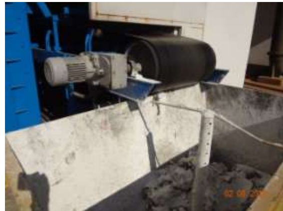
Figura 49 - Caçamba de resíduos retirados no gradeamento grosso coberto com Cal
