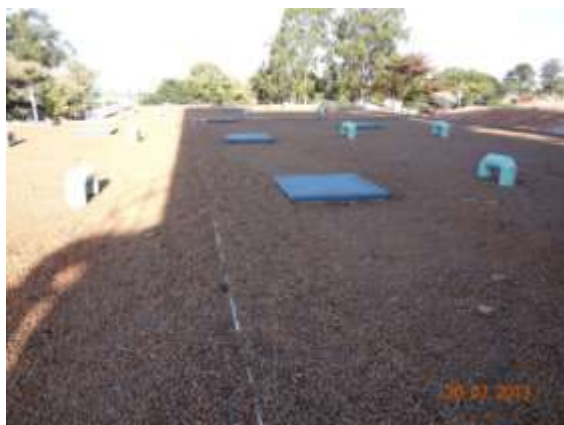
Figura 36 – Vista superior reservatório apoiado
