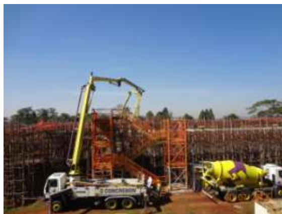
Figura 22 - Obras de ampliação da ETA
