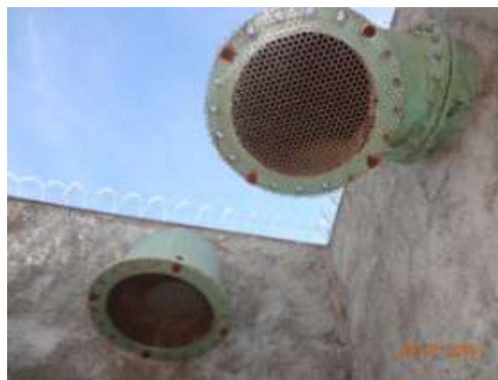
Figura 37 - Detalhe da tela de proteção do tubo extravasor
