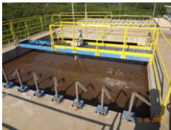
Figura 51 - Desarenador
