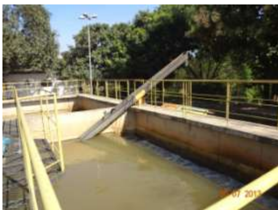
Figura 10 - Desarenador
