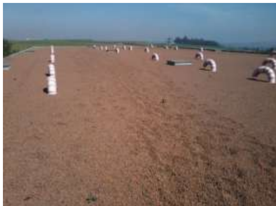
Figura 38 - Vista superior do reservatório Capim Fino
