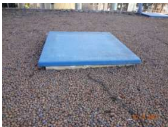
Figura 34 - Detalhe tampa de inspeção reservatório apoiado
