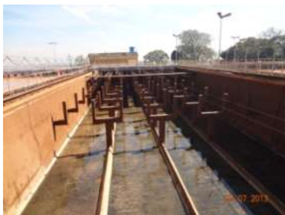
Figura 17 - Limpeza do decantador
