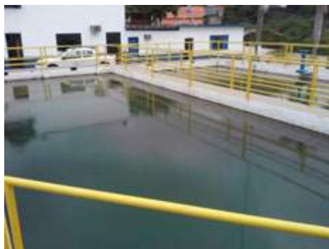
Descrição(3): Floculador hidráulico (chicanas verticais)
