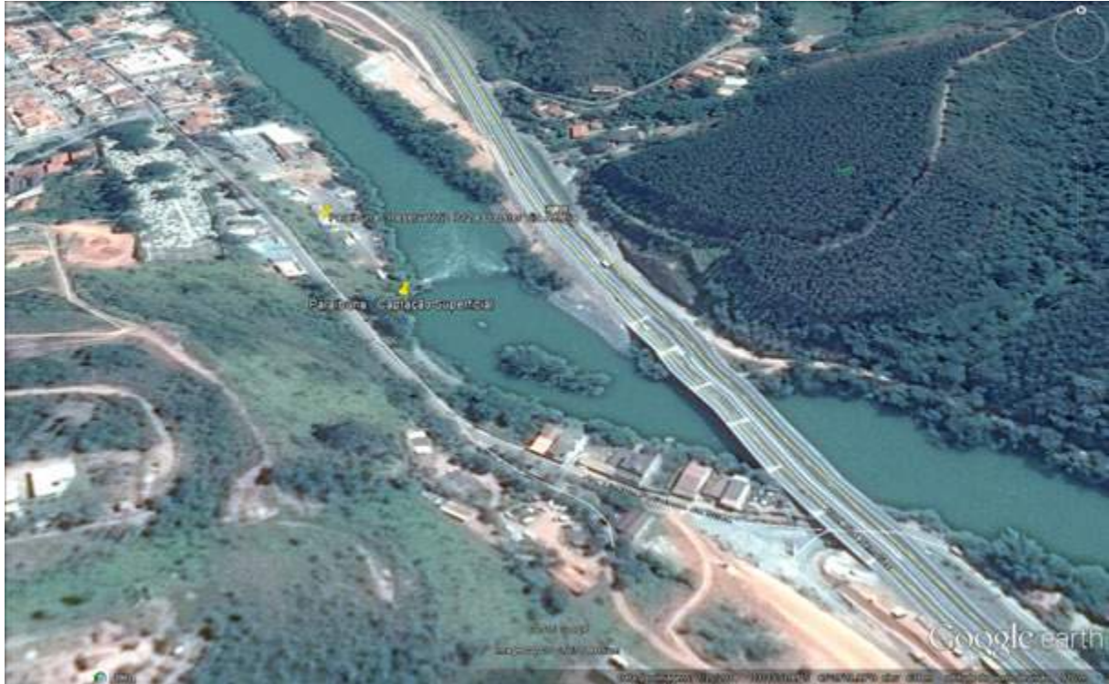
Figura 4 - Imagem de satélite da Captação no Rio Paraíba do Sul
