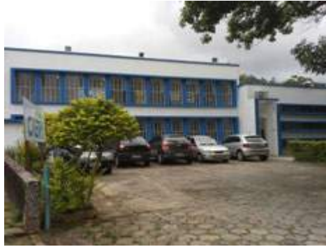
Descrição(1): Fachada da ETA, reformada apos concessão
