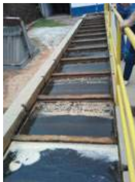
Descrição(3): Floculador hidráulico (chicanas verticais)
