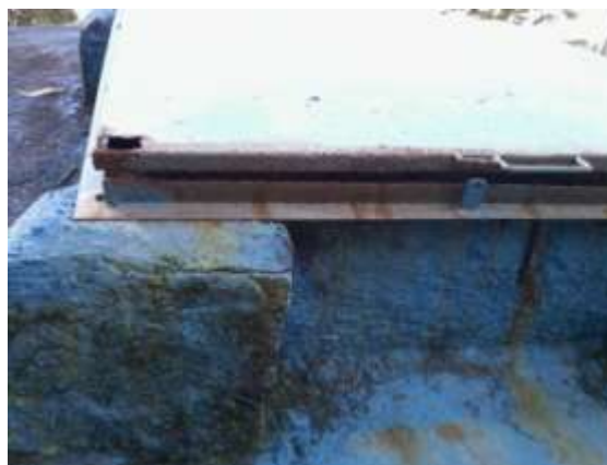
Figura 29 - Tampa de inspeção
