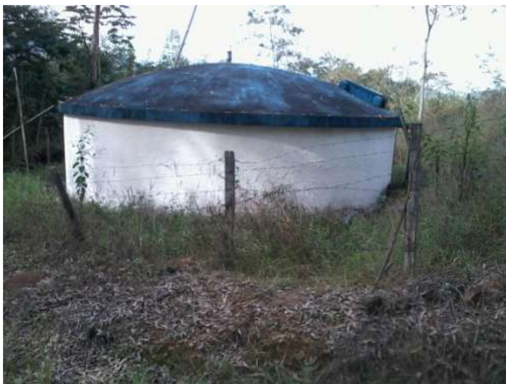
Figura 38 - Reservatório Caixa Alta
