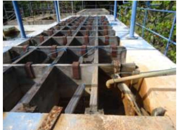
Figura 15 - Floculação com Chicanas
