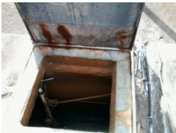
Figura 24 - Interior do reservatório enterrado
