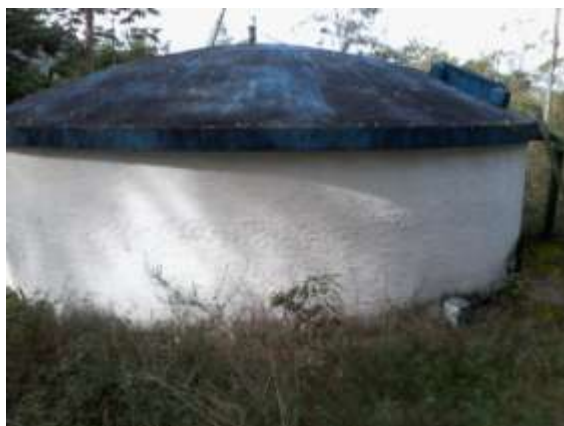
Figura 39 - Reservatório Caixa Alta
