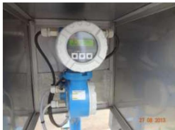
**Figura 22 - Medidor de vazão**
