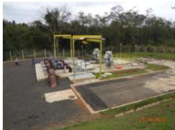
**Figura 20 - Elevatória de esgoto bruto com gradeamento grosso**
