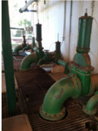
Descrição(6): Vista das tubulações do filtro, com vazamentos
