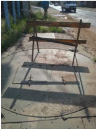
Descrição(1): aspecto externo da elevatória
