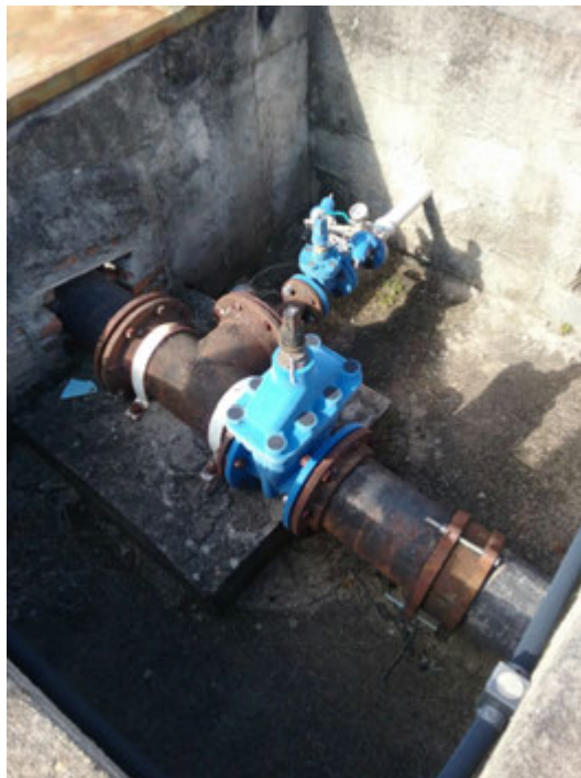
Descrição(3): Tubulação de saída e válvula antecipadora de ondas
