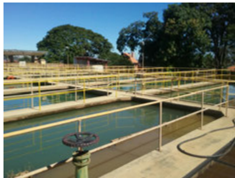
Descrição(3): Vista geral dos decantadores
