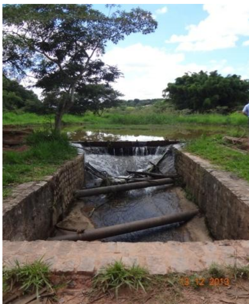
Figura 7 - Detalhes do enrocamento para acumulação de água
