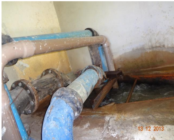
Figura 17 - Entrada da água bruta na calha Parshall e aplicação de coagulante
