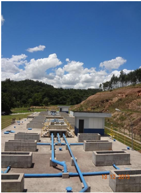
Figura 29 - Reator Anaeróbio de fluxo ascendente (RAFA)
