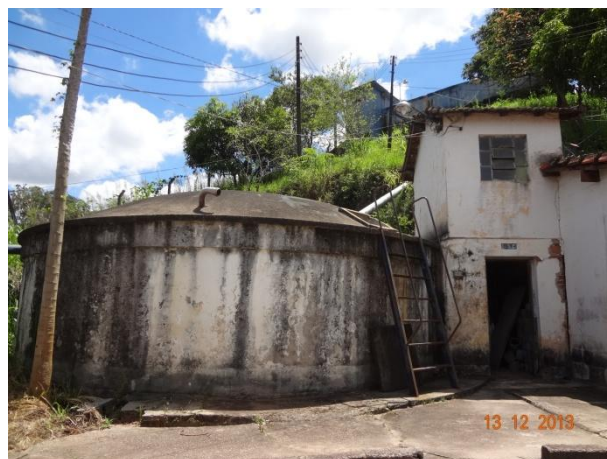
Figura 27 – Reservatório ETA próximo a captação
