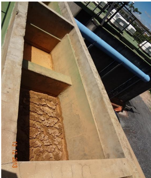
Figura 19 - Formação de flocos sobrenadantes nas chicanas
