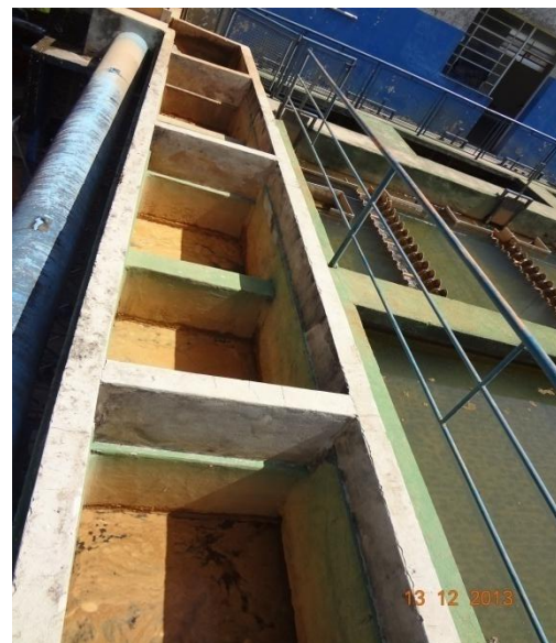
Figura 20 - Formação de flocos sobrenadantes nas chicanas
