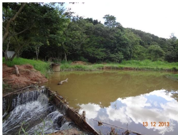
Figura 6 - Detalhes do enrocamento para acumulação de água
