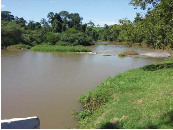
Descrição(1): Barramento Rio Jaguari
