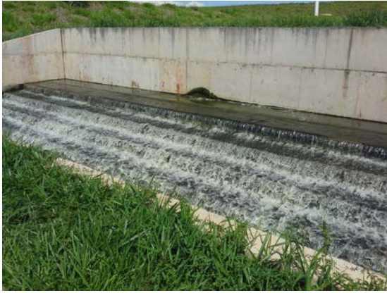
Descrição(7): Aeração do efluente final
