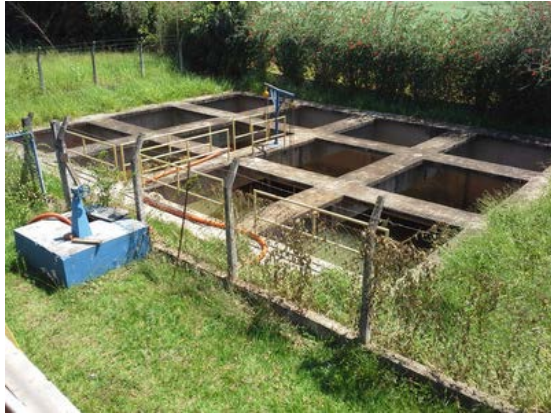
Descrição(4): Tanque para água de lavagem de filtros
