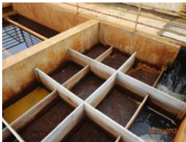
Figura 40 - Chicanas de madeira (módulo 4)
