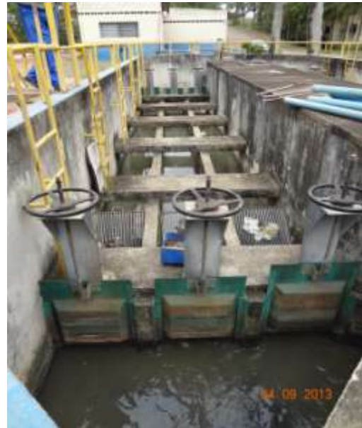
Figura 68 - Comportas e sistema de grades médias
