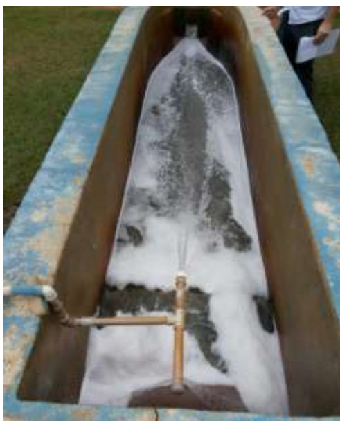
Figura 77 - Saída do efluente após decantador (detalhe do jato d'água para diminuir a espuma)
