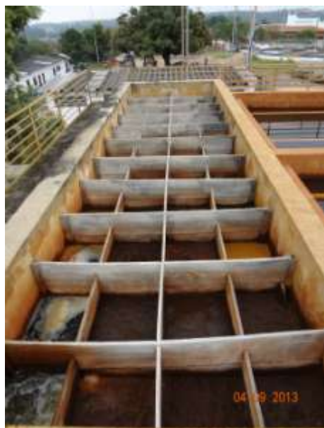
Figura 39 - Chicanas de madeira (módulo 4)
