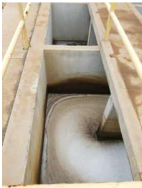
Figura 79 - Formação de espumas na chicana
