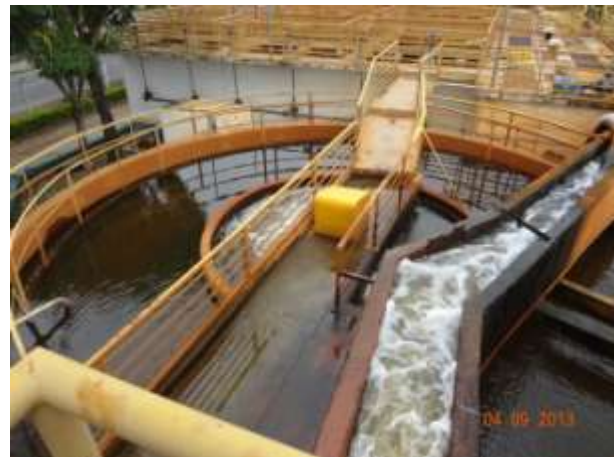
Figura 26 - Canal de entrada da água bruta
