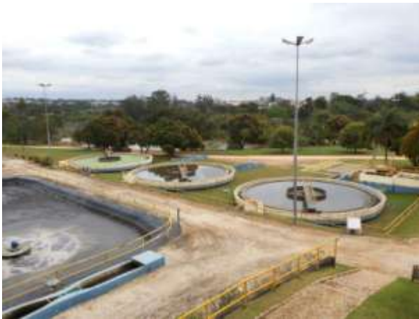
Figura 73 - Decantadores
