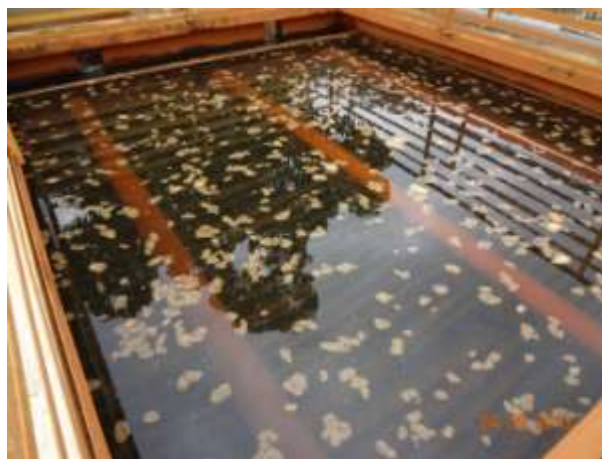
Figura 34 - Presença de flocos sobrenadantes no floculador
