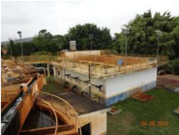
Figura 29 - Vista para o módulo 4 da ETA
