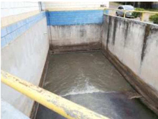
Figura 69 - Saída do desarenador
