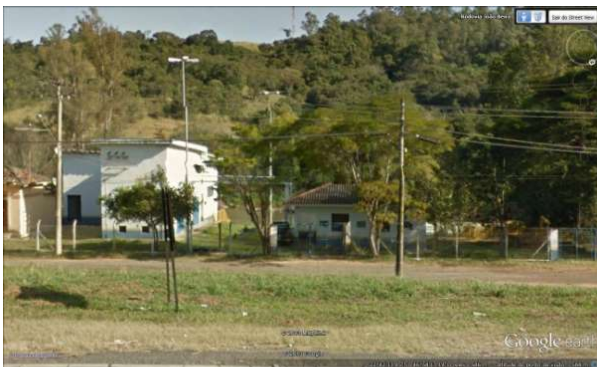
Figura 9 - Estação de captação de água
