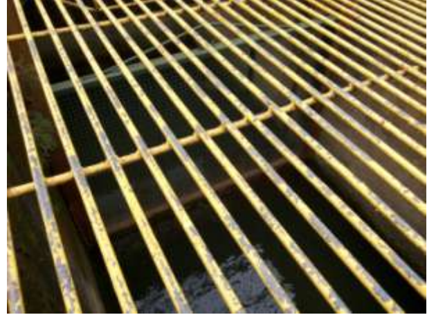
Figura 11 - Tela de retenção de sólidos médios
