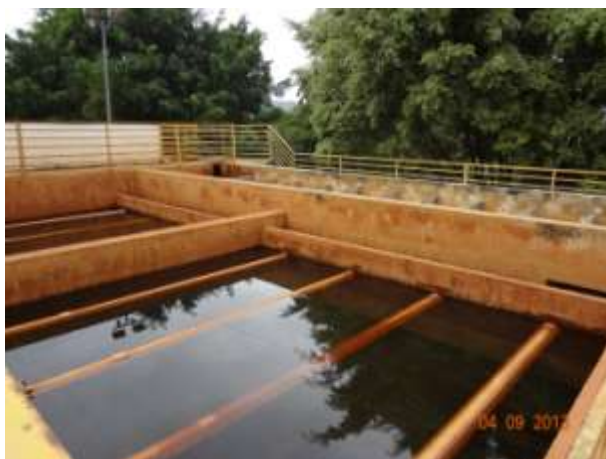
Figura 41 - Decantadores (módulo 4)
