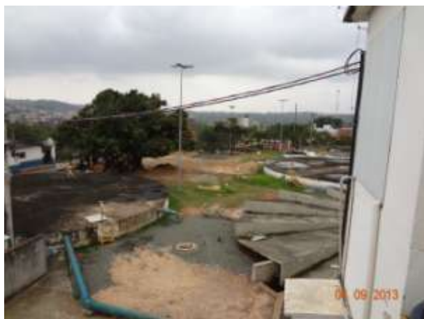
Figura 64 - Visão geral dos reservatórios
