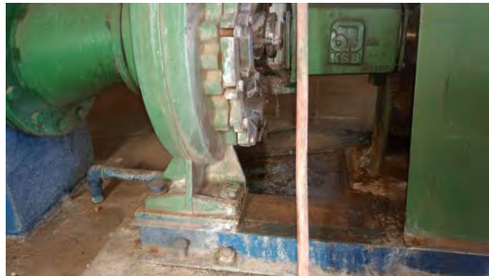
Descrição(4): Detalhe drenagem adequada da gaxeta
