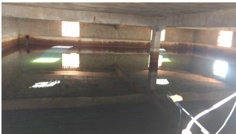
Descrição(4): Interior do reservatório
