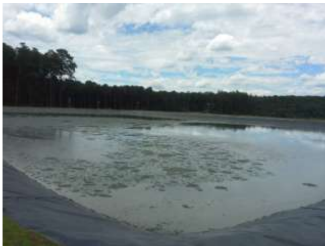
Descrição(8): Lagoa Anaeróbia
