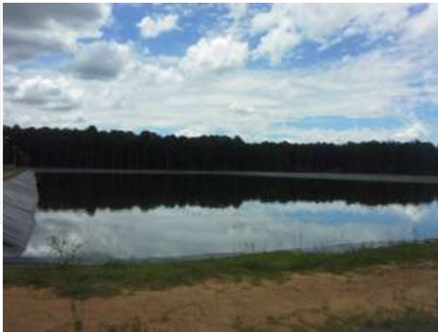
Descrição(10): Lagoa Anaeróbia
