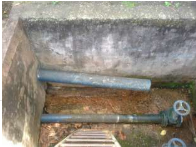
Descrição(4): Extravassor do reservatório apoiado
