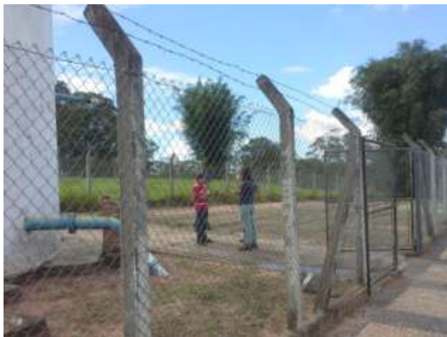
Descrição(4): Detalhe do Portão de Chegada (área cercada)
