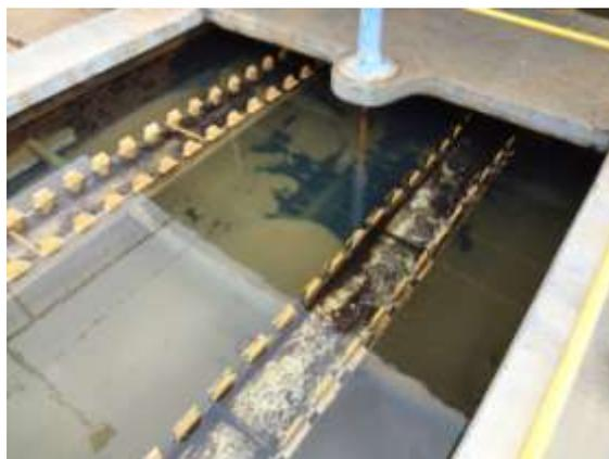
Figura 17 - Detalhe passagem de floco para filtros
