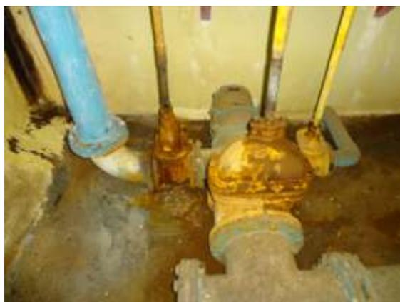
Figura 21 - Detalhe vazamento registro
