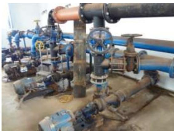
Figura 27 - Drenagem inadequada da gaxeta
