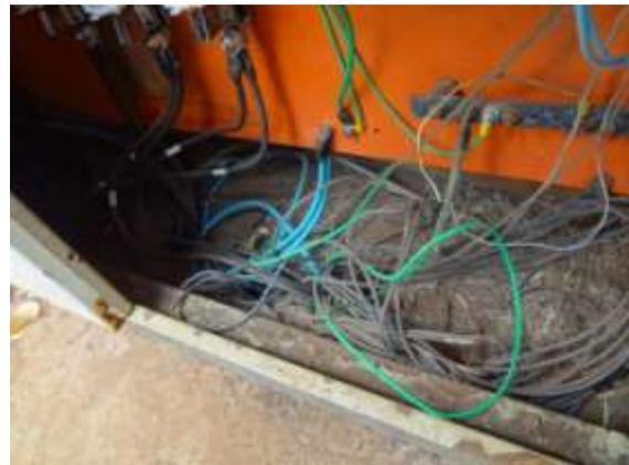
Figura 37 - Detalhe fios expostos painel elétrico
