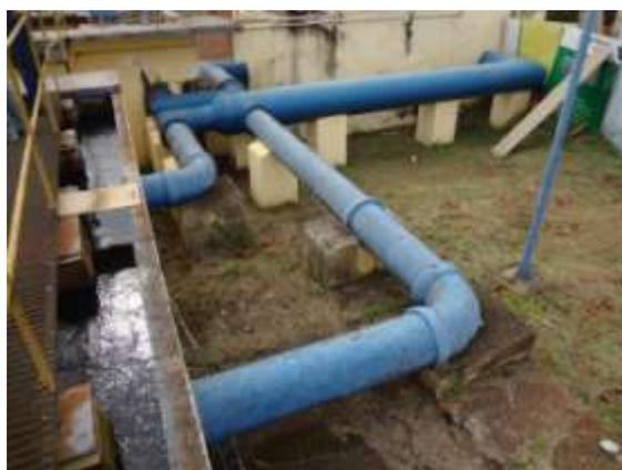
Figura 15 - Tubulação que conduz a água floculada ate os decantadores
