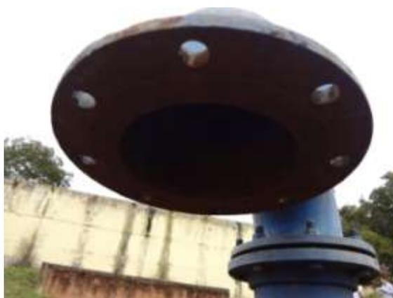
**Figura 32 - Detalhe tubo de ventilação (falta tela de proteção)**
