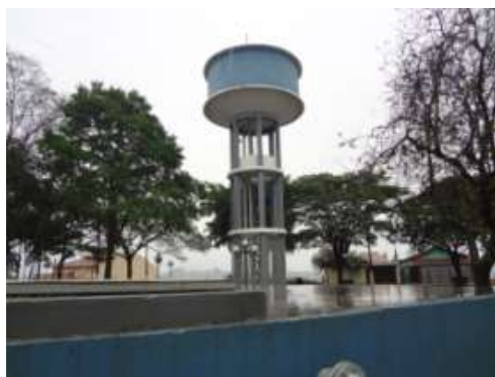
Figura 13 - Reservatório elevado para 150m³
