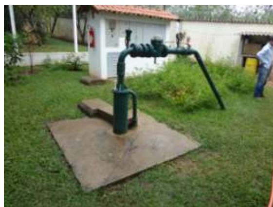
Figura 6 - Laje de proteção do poço
