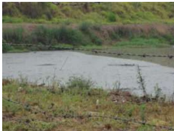
Figura 30 - Acúmulo de lodo na ETE
