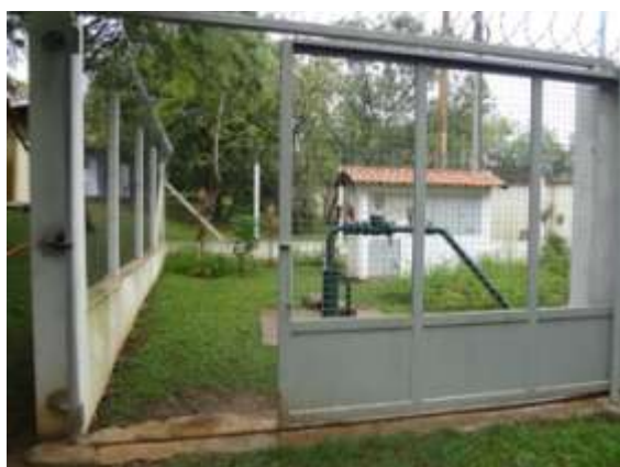
Figura 5 - Aspecto da área do poço nº 04
