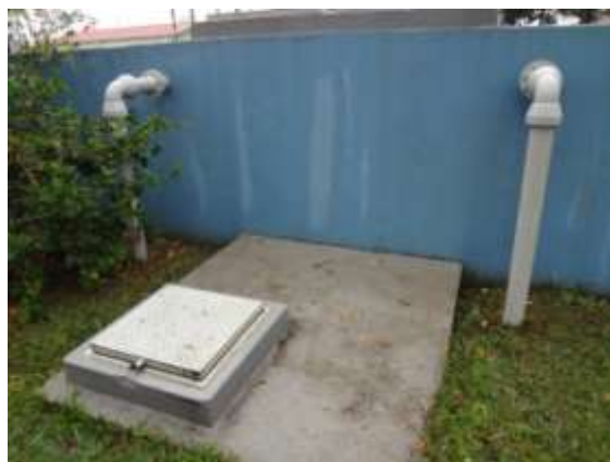
Figura 11 - Acesso para manobra e tubos extravazores do reservatório apoiado
