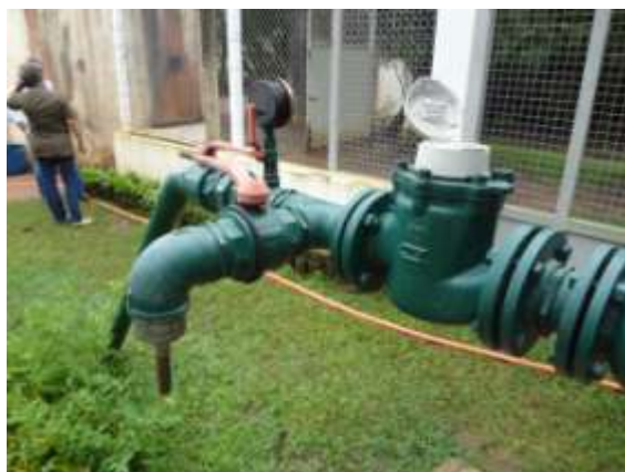
Figura 7 - Hidrômetro, manômetro e tomada para coleta
