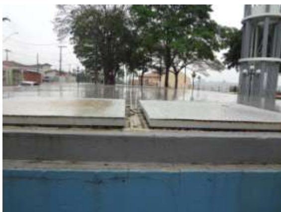
Figura 12 - Tampas de inspeção do apoiado
