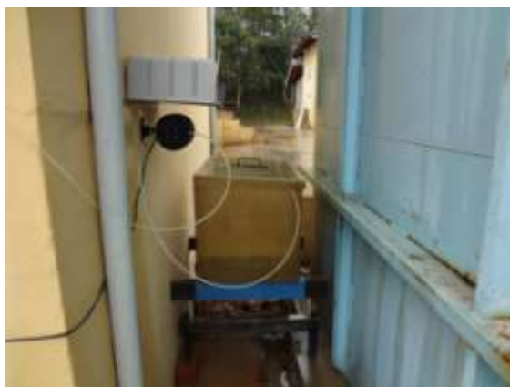
Figura 27 - Aplicação de Hipoclorito de Sódio
