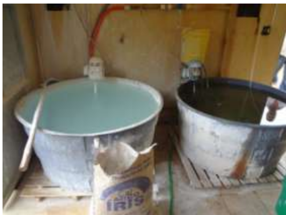
Figura 21 - Preparo das soluções de Cal Hidratada e Sulfato de Alumínio
