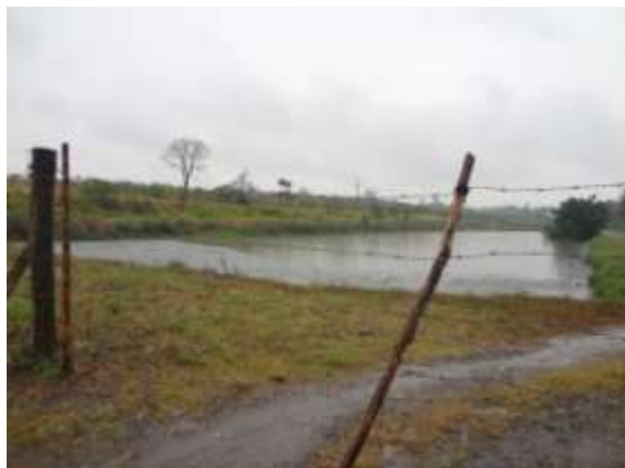
Figura 29 - Aspecto do acesso a ETE sem identificação ou proteção
