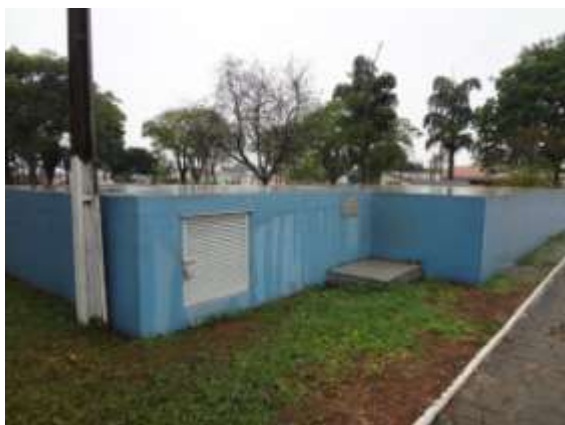
Figura 10 - Reservatório apoiado para 150m³
