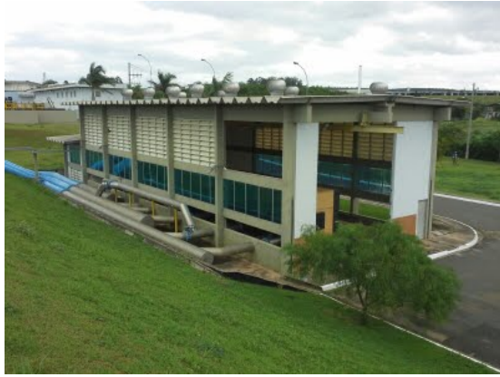
Descrição(14): Casa de sopradores
