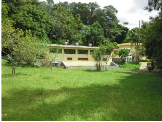
Descrição(3): Aspecto geral da estação elevatória
