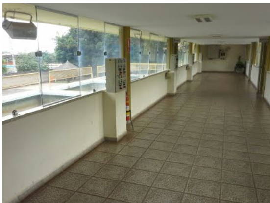
Descrição(6): Sala de comando de filtros
