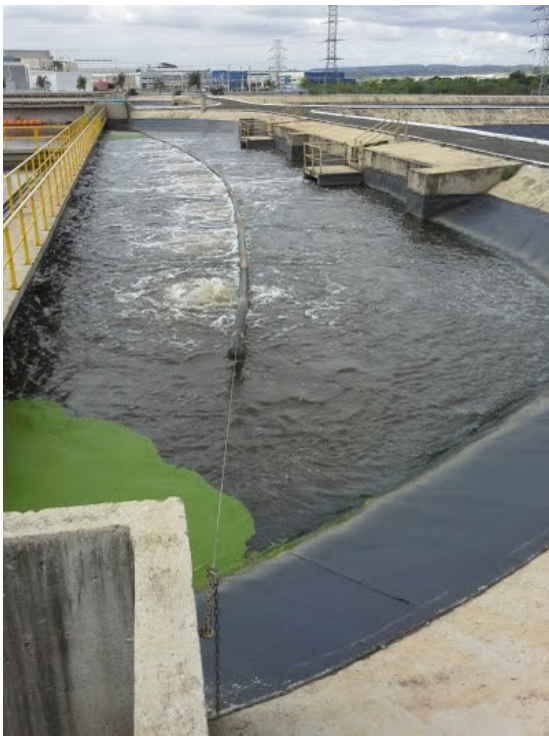
Descrição(7): Aeração final
