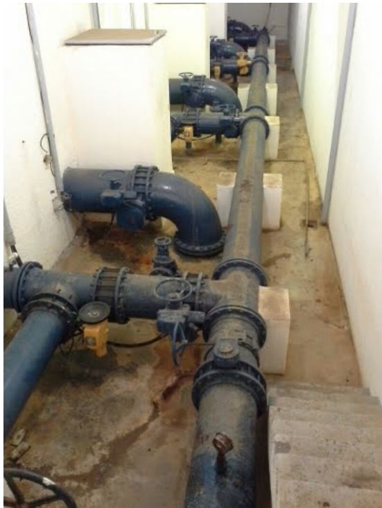
Descrição(8): Galeria da saída dos filtros
