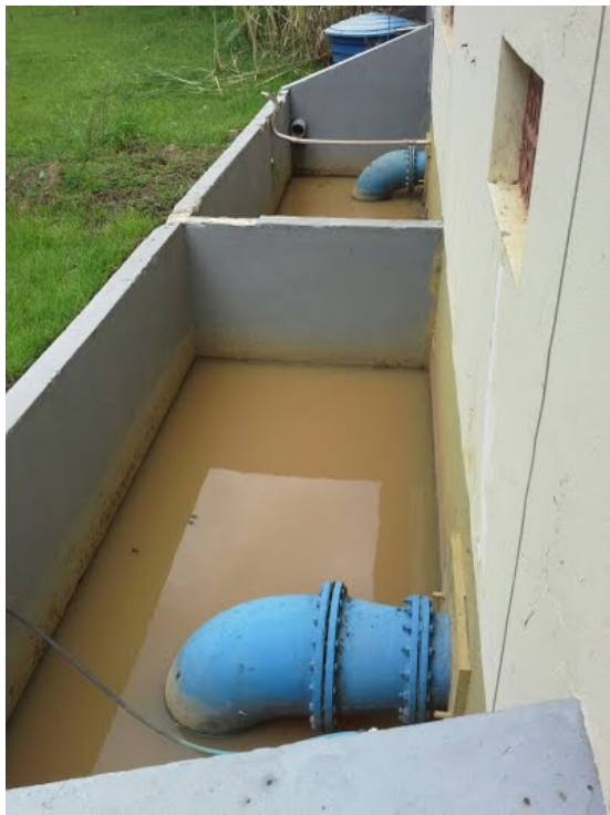
Descrição(4): Poço de sucção
