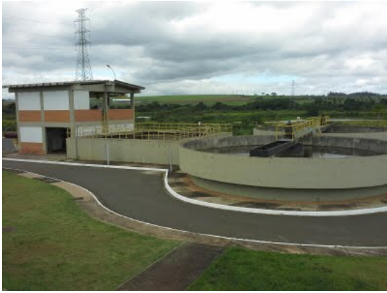
Descrição(8): Adensadores e desidratação de lodo por centrifugação
