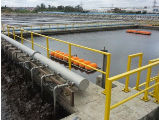
Descrição(6): Recirculo do lodo e decantadores
