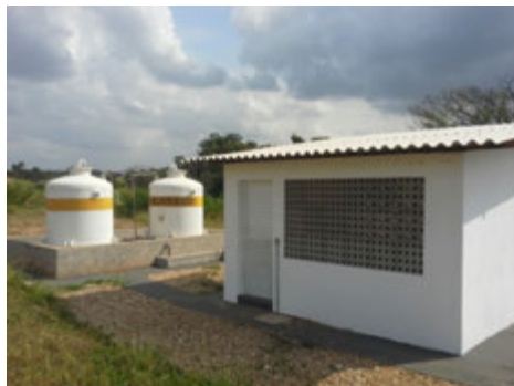
Descrição(7): Tanque de armazenamento de hipoclorito (em construção)
