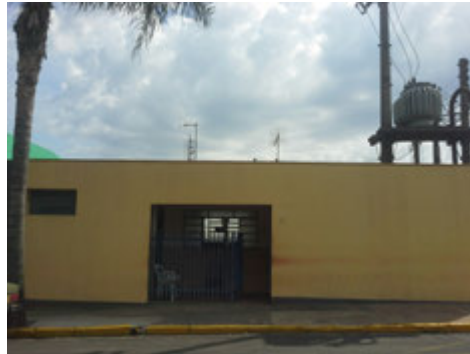
Descrição(5): Aspecto geral da EEA Centro
