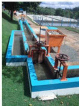
**Descrição(2):** Chegada do esgoto bruto, gradeamento e Calha Parshall
