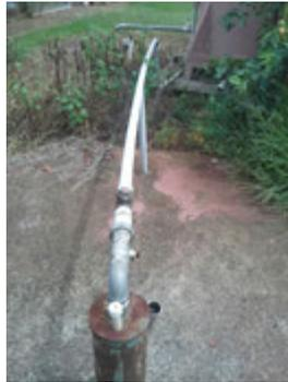
**Descrição(2):** Detalhe da tubulação de recalque e by-pass para reservatório em taça
