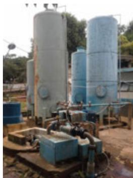
**Descrição(1):** Poço de sucção, conjuntos de recalque e conjuntos de filtros
