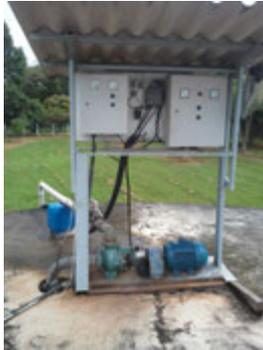
**Descrição(1):** Paineis elétricos e conjunto de recalque para reservatório elevado em aço Villa de Holanda
