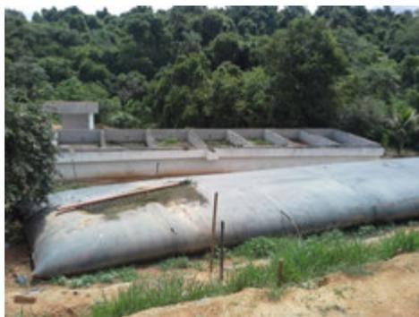
**Descrição(10):** Leito de secagem de lodo (ao fundo) e bags utilizados na remoção de lodo na última reforma (2015)
