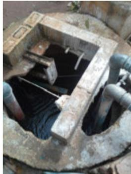
**Descrição(2):** Aplicação de Cal e sucção das bombas de recalque para filtros forçados
