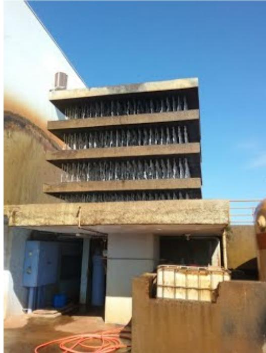
**Descrição(3):** Aerador da água bruta, a fim de oxidar o ferro.
