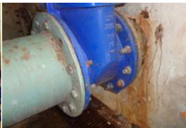
Figura 28 - Detalhe vazamento
