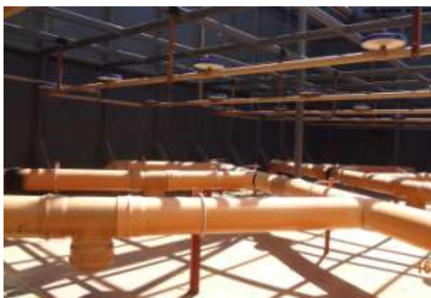
Figura 33 -Interior Biofiltro
