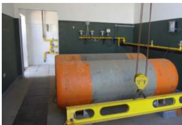
Figura 20 - Cilindros Cloro Gás
