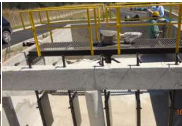
Figura 30 – Desarenador
