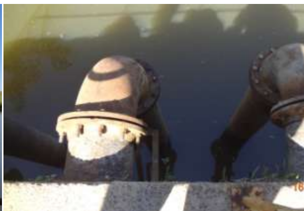
Figura 8 - Sucção aspirada na Represa
