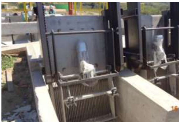
Figura 29 - Gradeamento Grosso
