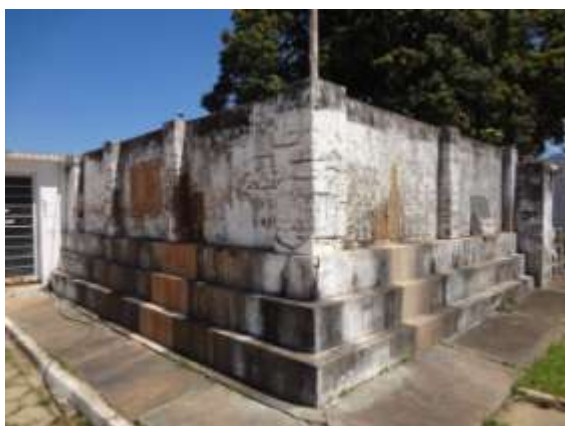
Figura 12 - Aspecto do reservatório em alvenaria
