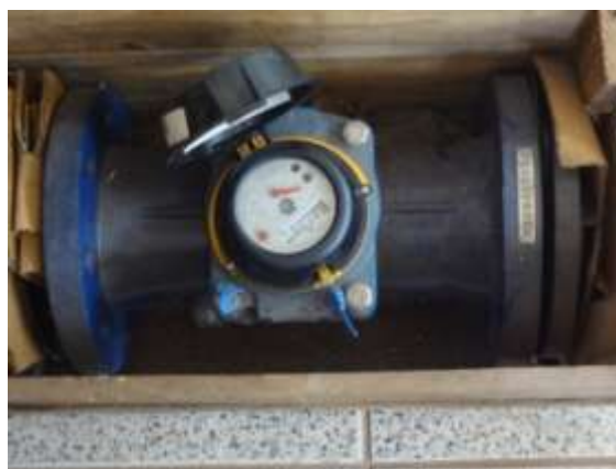
Figura 10 - Macromedidor a ser instalado na entrada da ETA
