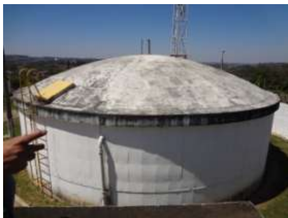
Figura 11 - Reservatório circular em concreto
