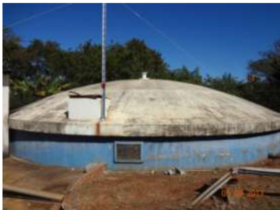
Figura 28 - Vista geral do reservatório Semi-Enterrado
