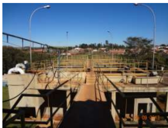
Figura 18 - Vista geral dos guarda corpo
