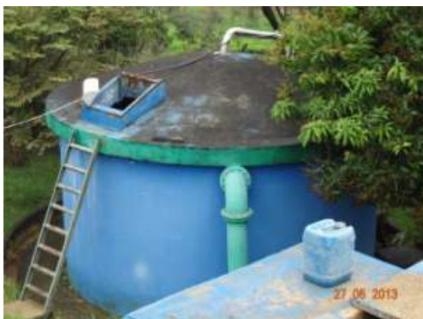
Figura 15 - Aspecto do reservatório após tanque de contato
