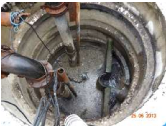
Figura 36 – Poço de Sucção
