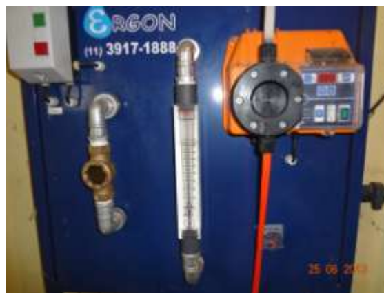
Figura 37 – Sistema de dosagem de polímero
