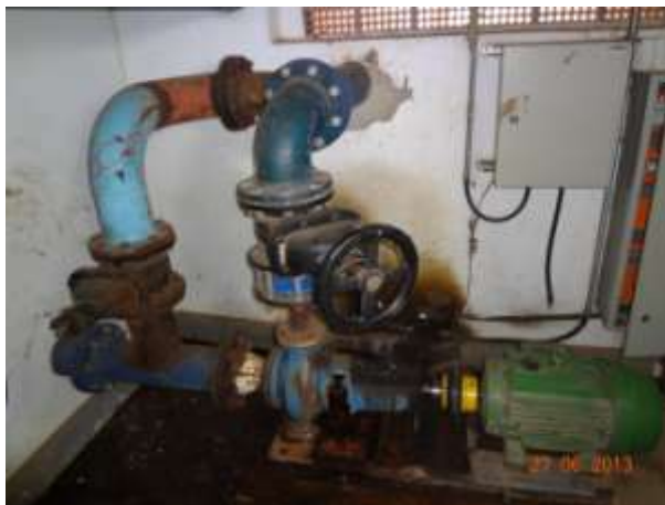
Figura 20 - Conjunto de recalque para Caraça
