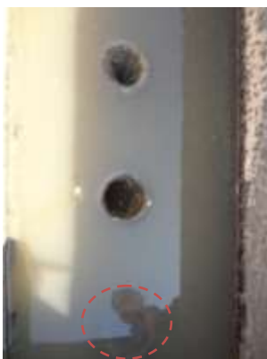
Figura 49 - Distribuição do efluente no reator com tubo obstruído
