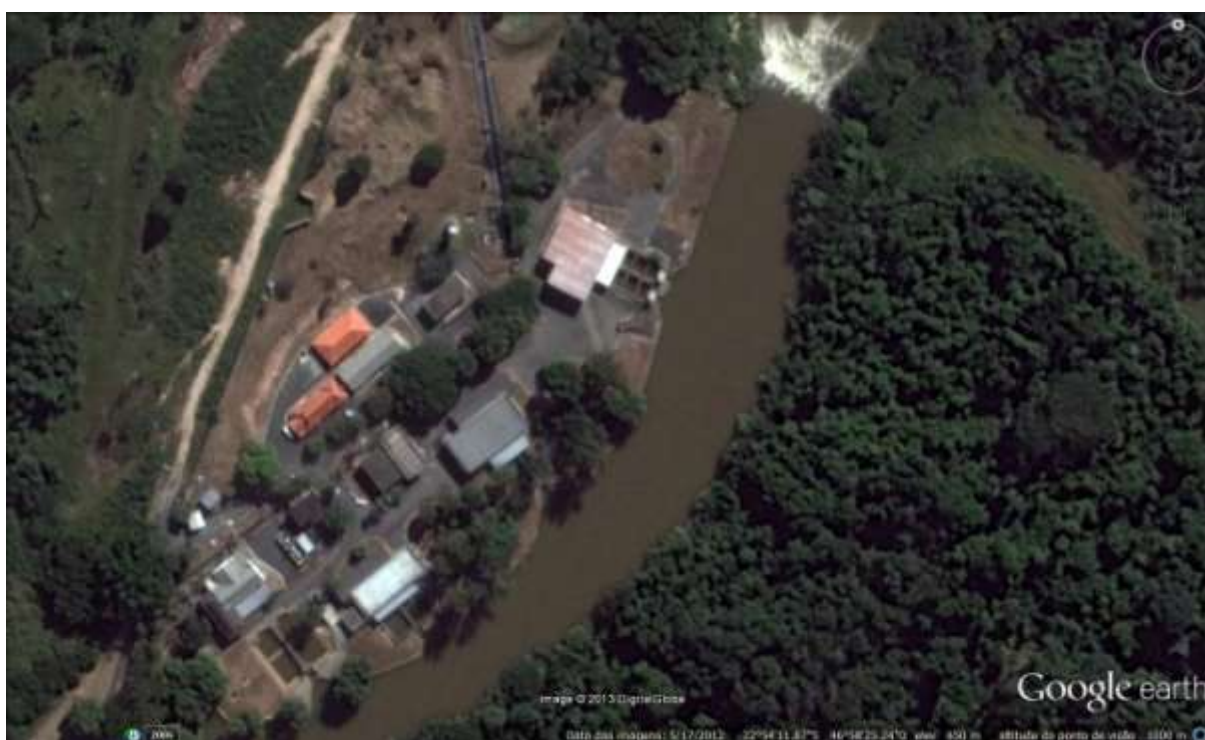
Figura 5 - Estação de captação de água
