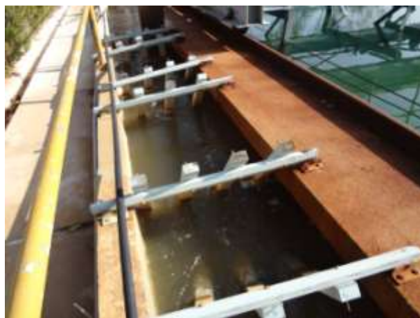
Figura 19 - Dispositivo de mistura de coagulantes
