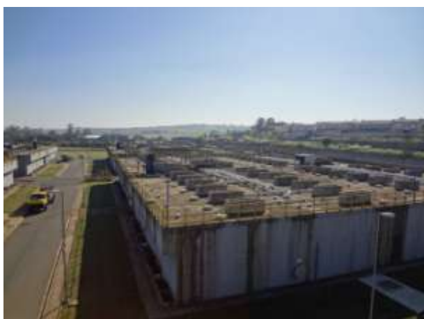
Figura 46 - Vista do Reator Anaeróbico de Fluxo Ascendente
