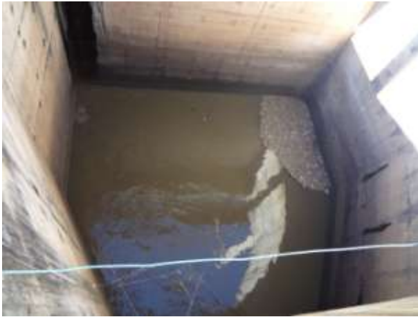
Figura 38 - Chegada do efluente (poço de sucção)
