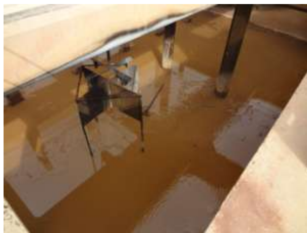
Figura 30 - Flocculador mecânico
