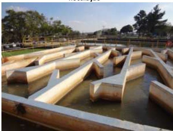
Figura 20 - Sistema de chicanas para mistura hidráulica
