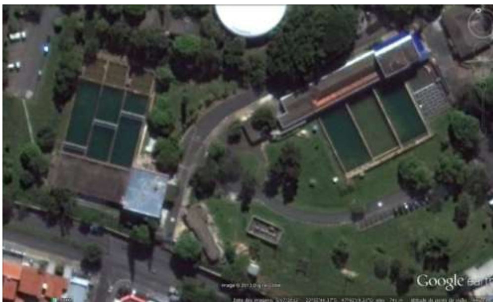
Figura 14 - Imagem de satélite da Estação de Tratamento de Água – ETA 1 e 2
