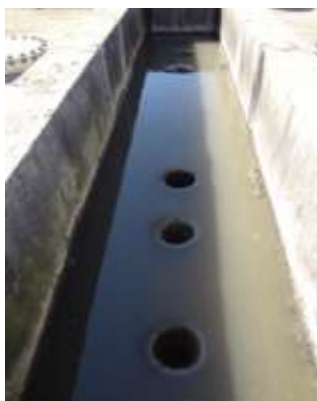
Figura 48 - Distribuição do efluente no reator
