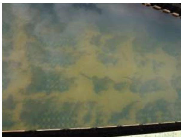
Figura 32 - Sólidos retidos no decantador
