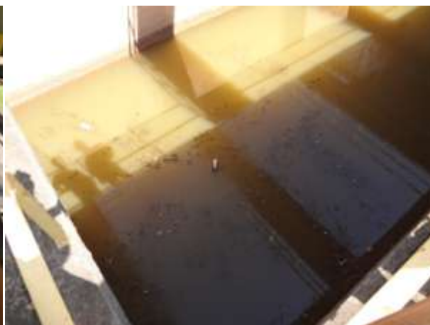
Figura 9 - Sólidos grosseiros sobrenadantes na caixa de areia
