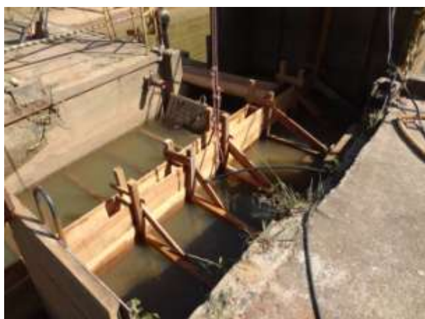
Figura 6 - Sistema de tratamento preliminar
