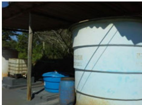
**Descrição(4):** Caixas e containers de produtos químicos líquidos, tais como: cloreto férrico que não é mais utilizado e o da solução de hipoclorito de sódio, quando é necessária a utilização da solução pronta para a aplicação na pré-cloração, pois para a cloração da água tratada existe a fábrica de cloro instalada.
