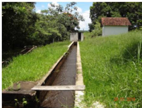
**Descrição(1):** Canalização em seção retangular, em alvenaria revestida, da Captação Superficial do Córrego Águas Claras, aduzida por gravidade até a ETA - UNICA
