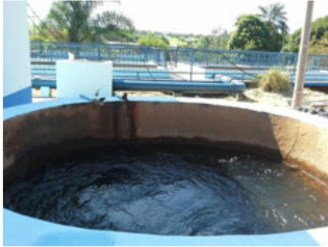
**Descrição(5):** Tanque da mistura hidráulica rápida do floculante, do cloro na pré cloração e da aplicação da mistura da cal hidratada, antes de entrar nos floculadores dos dois módulos da ETA convencional.
