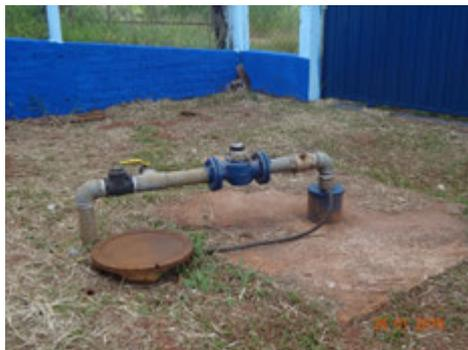
**Descrição(1):** Poço Tubular Profundo na ETA – Única, equipado com medidor de vazão (hidrômetro), registro de gaveta, válvula de retenção, torneira para coleta de amostra de água e laje de proteção em concreto
