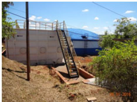
**Descrição(7):** Outra vista do Reservatório apoiado da ETA, que receberá água tratada também da nova ETA compacta e metálica situada ao lado, mostrando o detalhe da escada de acesso à mesma e os guarda-corpos e corrimões, de acordo com as normas de segurança.
