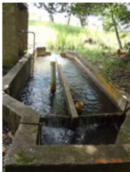
**Descrição(11):** Caixa de areia em duas seções, com grade de retenção de resíduos grosseiros no final do canal de adução da Captação Superficial Águas Claras que antecede a canalização na tubulação de seção circular fechada que transporta a água bruta até a ETA - Unica
