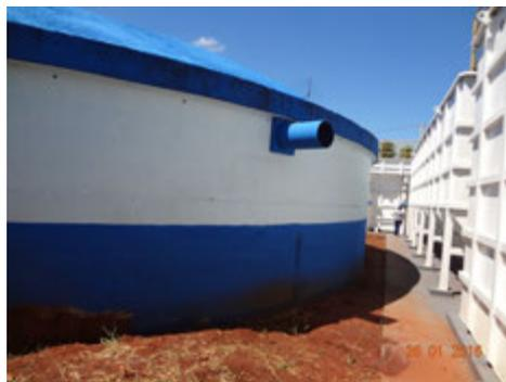
**Descrição(6):** Reservatório apoiado da ETA que receberá água tratada também da nova ETA compacta metálica situada ao lado (pintada na cor branca).
