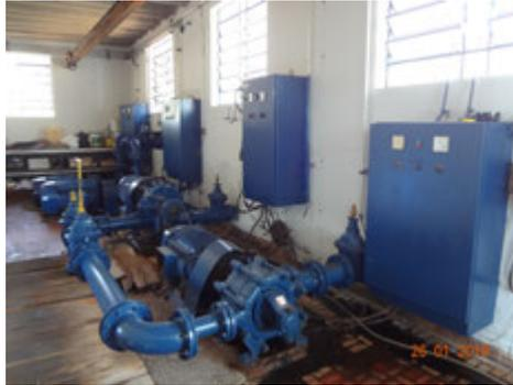
**Descrição(9):** Vista Geral dos quatro Conjuntos moto-bombas das três EEATs – ETA, mostrando que há um Painel de Comando Elétrico para cada Conjunto Moto-bomba, a boa iluminação natural, ventilação e o monotrilha para auxílio na extração dos motores e bombas para a manutenção
