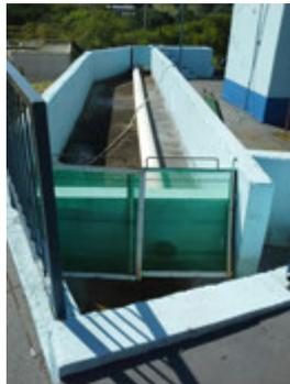
**Descrição(3):** Canal alternativo de desvio da entrada da água bruta na ETA, com grades para conter material grosseiro.
