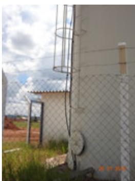
**Descrição(1):** Reservatório Apoiado metálico – Santa Cecília, com detalhes da escada com guarda-copos, tubulação de saída, cabos elétricos do monitoramento dos níveis de água reservados e transmitidos por telemetria à CCO na ETA- Única. Há uma pequena edificação que serve de almoxarifado para guardar ferramentas de manutenção da limpeza da área.
