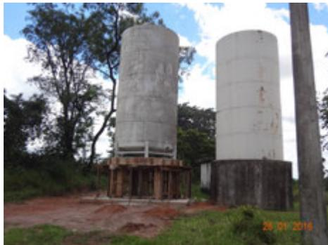
**Descrição(2):** Reservatórios Elevados metálicos Boa Vista – marginal à Rodovia – um em funcionamento e outro recentemente instalado sobre as bases de concreto armado ainda não desformada e não em funcionamento
