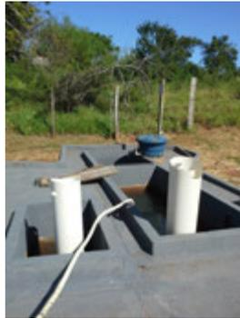
**Descrição(2):** Outra vista dos canais de entrada da água bruta que permitem operações e manobras para desvios de água antes da entrada na ETA, conforme a conveniência da limpeza, manutenção ou o desvio de águas aparentemente impróprias ao tratamento, ou seja, visivelmente com alta turbidez e cor.
