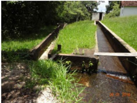
**Descrição(10):** Seção de desvio e extravazão do excesso de água no canal de adução da Captação Superficial Águas Claras de volta ao leito natural do mesmo.
