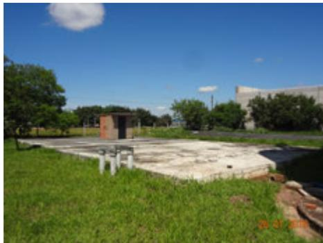
**Descrição(2):** Vista do Reservatório de concreto, enterrado de 500 m3 , situado no Sistema Campos Elísios I e a correspondente EEAT – 02 (Casa de máquinas é a pequena Edificação –ao fundo da foto, a qual abriga um conjunto moto-bomba somente) que alimenta os Reservatórios metálicos m3 - Polícia Rodoviária Federal
