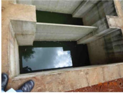
**Descrição(17):** Detalhe de uma célula do tanque de contato recém construído por exigência da CETESB para a desinfecção final do efluente tratado pelo Sistema de Lagoas da ETE - Central
