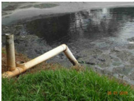
**Descrição(4):** Detalhe da Tubulação de chegada do esgoto bruto na primeira lagoa anaeróbia da ETE – Central que vem do Tratamento Preliminar
