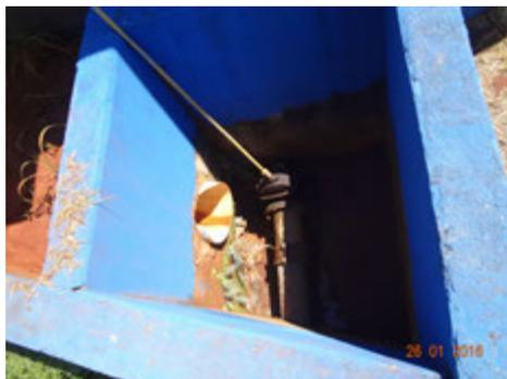
**Descrição(2):** Caixa de inspeção com o registro na tubulação de saída do Reservatório apoiado circular de 1.000 m3 na ETA
