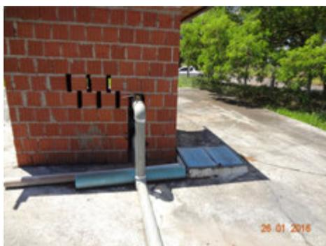
**Descrição(3):** Edificação (Casinha) da casa de Bombas da EEAT – Reservatório Apoiado Santa Cecília (externo a este Sistema de Reservação Campos Elísios I, mostrando a tubulação externa de recalque e aberturas de ventilação natural nas paredes da casa de Bombas
