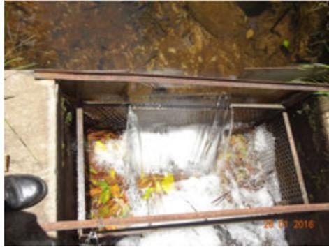
**Descrição(2):** Vertedor retangular com cesto de retenção de resíduos de folhas e materiais grosseiros na seção de transição entre o leito natural do Córrego Águas Claras e a seção retangular do canal artificial em alvenaria de adução de água bruta da Captação Superficial
