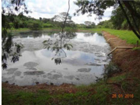
**Descrição(6):** Vista geral da primeira lagoa anaeróbia do total de uma sequência de 03 lagoas anaeróbias seguidas de 02 lagoas Facultativas do Sistema da ETE - Central
