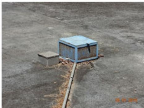
**Descrição(3):** Sensor de nível da água do Reservatório enterrado no Sistema Campos Elísios I que alimenta os Reservatórios Elevado Campos Elísios I em Concreto, situado no próprio local e que alimenta o Reservatório Elevado metálico Campos Elísios II e Reservatórios Polícia Rodoviária junto à Rodovia Estadual Itirapina –Jaú. A transmissão dos dados é feita por telemetria à CCO situada na ETA
