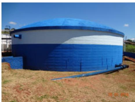
**Descrição(3):** Vista Geral do Reservatório de água tratada, circular, apoiado, em concreto, volume de reservação 1.000 m3 na ETA, mostrando o detalhe da tubulação de saída e adução para as duas EEATs na própria ETA.
