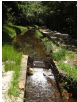
**Descrição(4):** Vista Geral do Canal natural, da seção do vertedor e do canal retangular em alvenaria de adução de água da Captação do Córrego Águas Claras.
