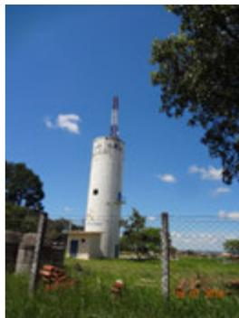
**Descrição(1):** Vista do Reservatório Elevado em Concreto – Campos Elísios I, com o detalhe da torre de para-raios, sinalização noturna e antena de transmissão de dados à CCO na ETA dos níveis dos Reservatórios Elevados e dos dois enterrados do Sistema Campos Elísios I situados todos neste mesmo local
