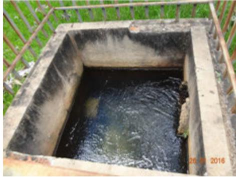
**Descrição(6):** Caixa de passagem de interligação do canal de seção aberta com a tubulação fechada que transporta a água bruta da Captação Águas Claras até a ETA, por gravidade.
