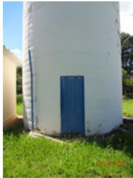
**Descrição(3):** Reservatório Elevado em concreto – Campos Elísios I, mostrando os detalhes da Porta de inspeção do barrilete inferior, cabo terra do para-raios e parte da edificação ao lado que serve de almoxarifado para guardar ferramentas de manutenção do local
