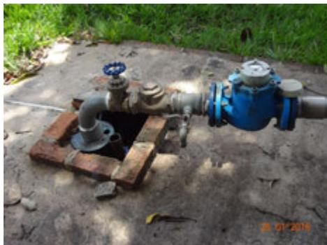
**Descrição(1):** Poço Tubular Profundo – Águas Claras, equipado com medidor de vazão (hidrômetro), válvula de retenção, registro de gaveta e torneira para a coleta de água para análise, Laje de proteção, tubo medidor de nível
