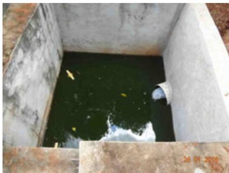
**Descrição(16):** Caixa de passagem da saída do esgoto tratado e realizada a desinfecção no tanque de contato antes do lançamento do efluente tratado pela ETE- Central, no Rio Jacaré Pepira em sua margem direita.
