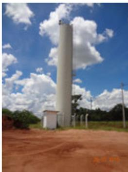
**Descrição(2):** Vista Geral do Reservatório Apoiado metálico – Santa Cecília, com detalhes do guarda-corpos na cobertura, antena de transmissão de dados da telemetria, para-raios e sinalização noturna
