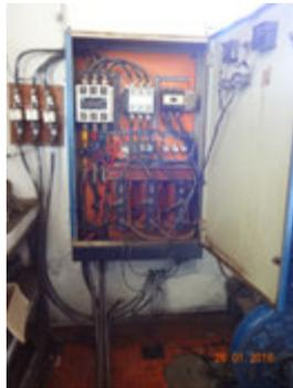
**Descrição(1):** Painel de Comando Elétrico individual de um Conjunto motobomba da EEAT - ETA
