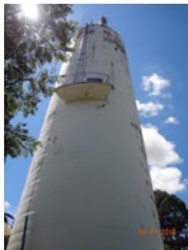
**Descrição(4):** Reservatório Elevado em concreto – Campos Elísios II, mostrando os detalhes do patamar intermediário com uma Porta de inspeção do barrilete superior, escada tipo marinheiro de acesso à cobertura com guarda corpo e cabo de aterramento do para-raios
