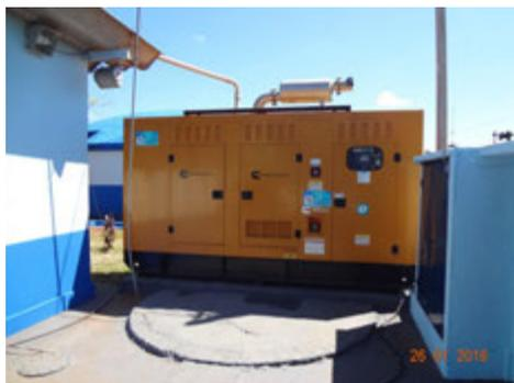
**Descrição(26):** Gerador de Energia Elétrica à diesel para suprir a falta de energia elétrica da rede pública e não interrupção do tratamento e bombeamento da água tratada para a distribuição
