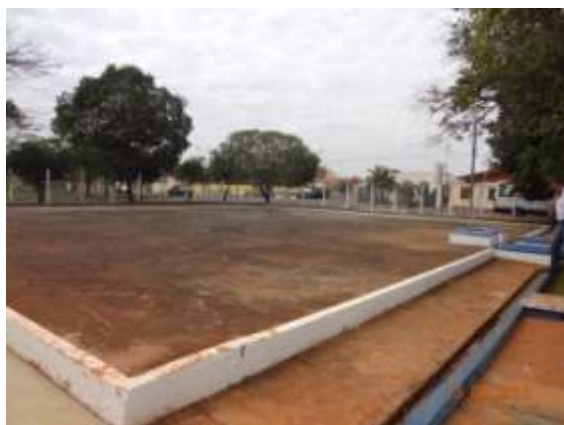
Figura 28 - Vista superior do reservatório
