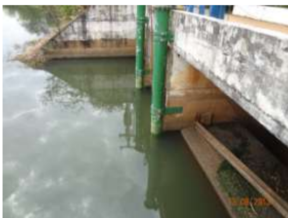
Figura 7 - Sucção afogada da captação
