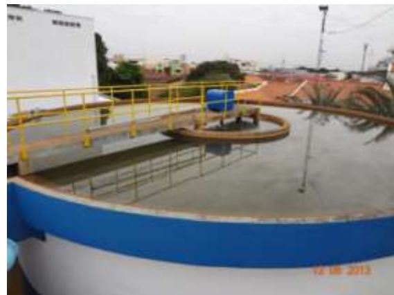
Figura 16 - Decantador
