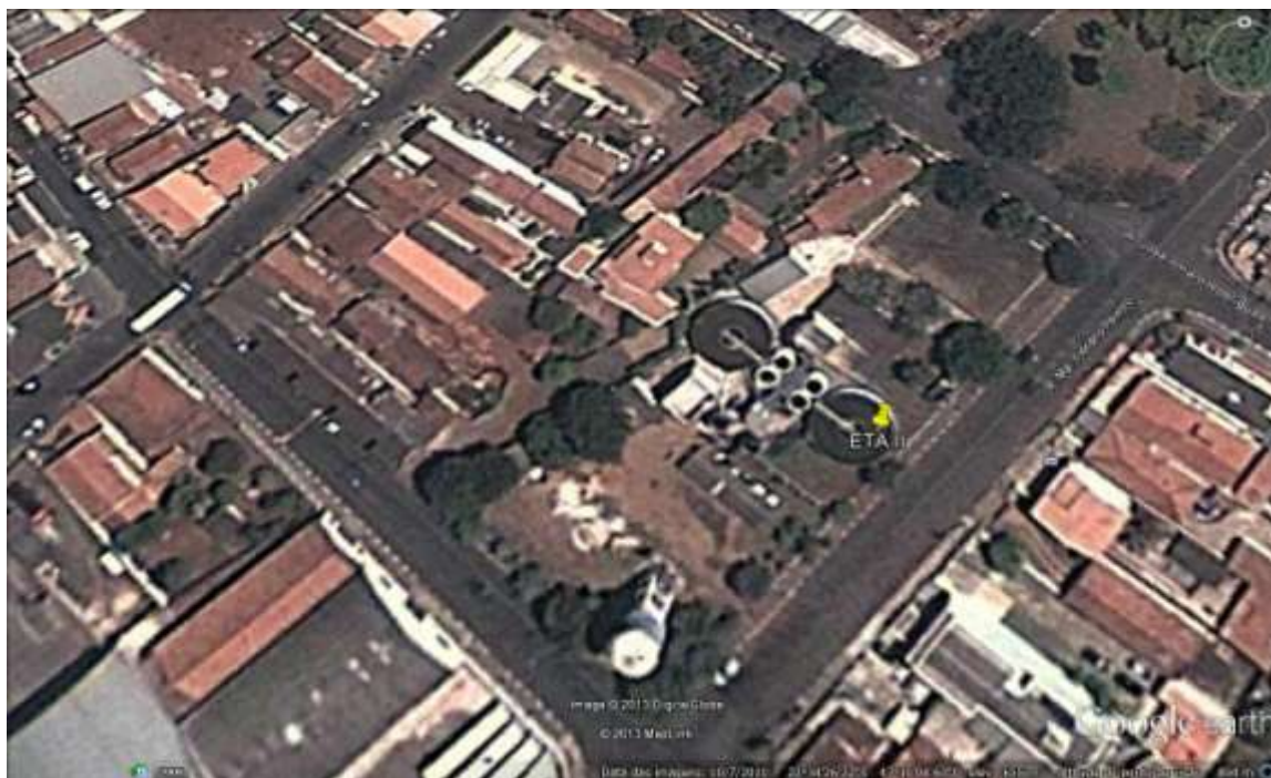
Figura 12 - Imagem de satélite da Estação de Tratamento de Água ETA II
