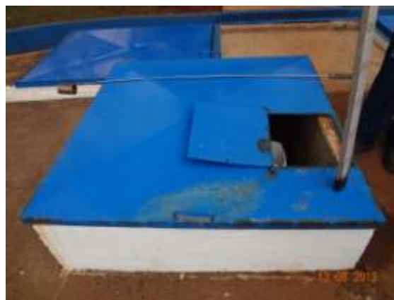
Figura 29 - Detalhe das tampas de inspeção
