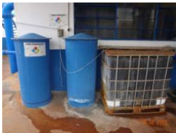
Figura 20 - Mangueiras de aplicação de Flúor que necessitam ser fixada adequadamente
