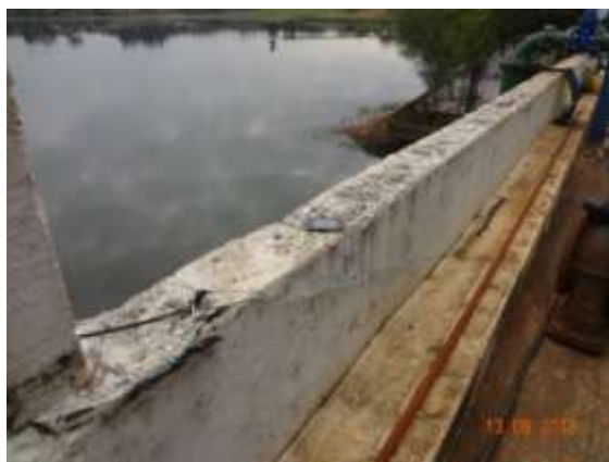
Figura 11 - Cabos elétricos expostos ao tempo
