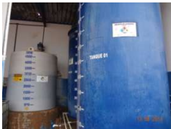
Figura 18 - Tanques armazenamentos produtos químicos
