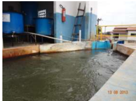
Figura 14 - Entrada água na calha Parshall
