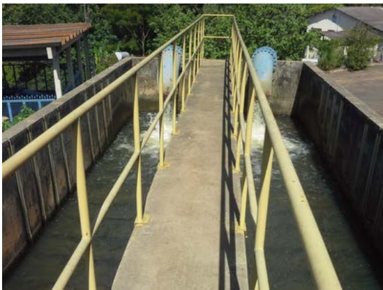
Descrição(3): Chegada do primeiro bombeamento e chicanas para sedimentação
