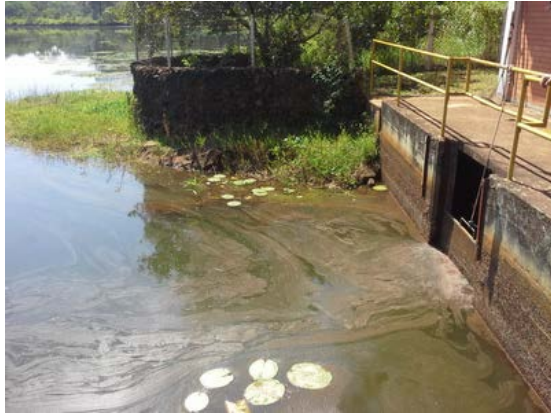
Descrição(2): Tomada de água
