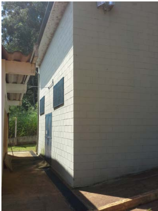
Descrição(9): Cabina de transformadores
