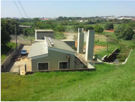
Descrição(2): Estação elevatória
