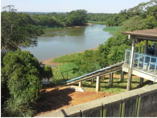
Descrição(2): Recalque para pré-tratamento
