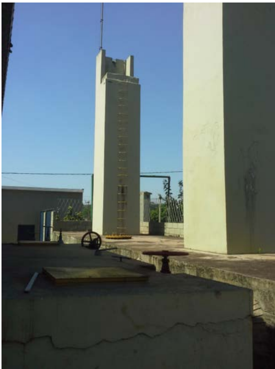
Descrição(3): Torre de carga e sucção
