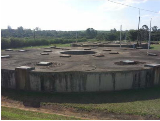
Descrição(6): Reator anaeróbio
