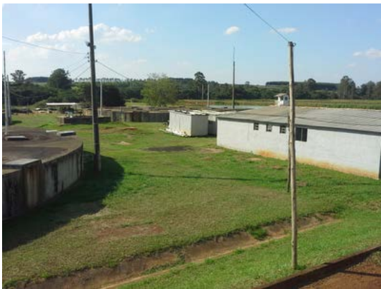
Descrição(7): Reatores e lagoas desativadas ao fundo e canteiro de obras de reforma, em primeiro plano
