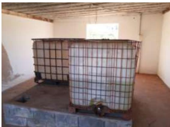
Figura 37 - Tanque armazenamento hipoclorito
