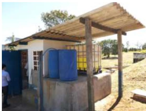
Figura 13 - Tanques de armazenamento dos produtos químicos
