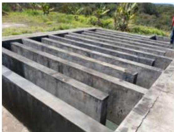
Figura 38 - Tanque de Contato
