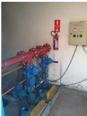
Figuras 8 a 10 - Gerador, bombas e painel novos na EEB Jd. Marília.
