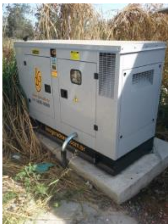
Figuras 8 a 10 - Gerador, bombas e painel novos na EEB Jd. Marília.
