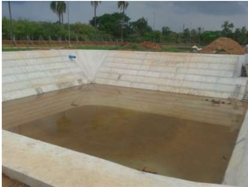
Figura 8 – Ampliação da ETE Camanducaia
