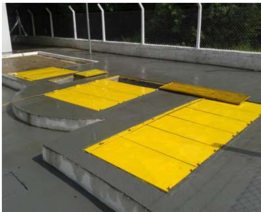
Figura 9 – Construção do Sistema de Coleta e Afastamento de Esgoto Fase III (finalizado e em funcionamento)
