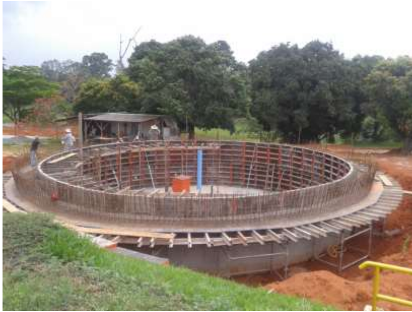
Figura 7 – Ampliação da ETE Camanducaia
