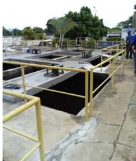
Descrição(10): Floculador da ETA I em processo de reforma
