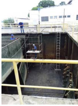
Descrição(7): Reforma em andamento de decantador da ETA I Imagem(8)
