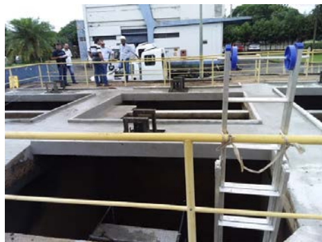
Descrição(6): Reforma de floculador da ETA I
