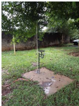
Descrição(9): Vazamentos eliminados em chuveiros e lava-olhos Imagem(10)
