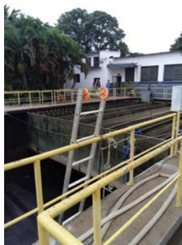
Descrição(5): Reforma de decantador da ETA I Imagem(6)
